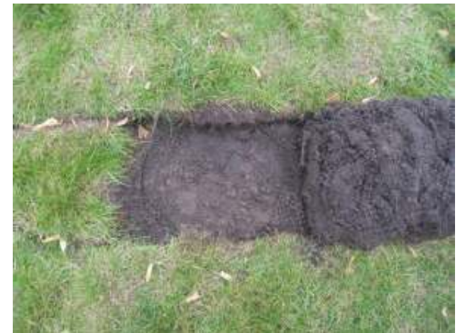
Voorbeeld van het funderen van gras door middel van netten. Dit is steviger en het gras blijft mooier dan bij bijvoorbeeld ritterplaten.
